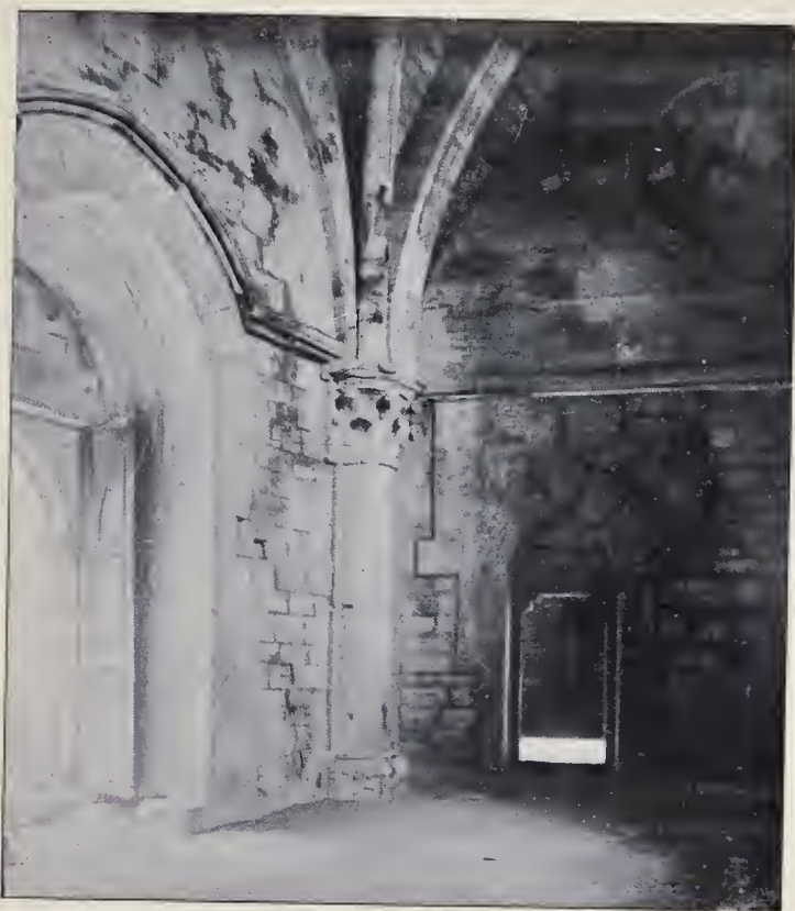
FIG. 349. — CASTEL DEL MONTE. SALLE DU REZ-DE-CHAUSSÉE.
