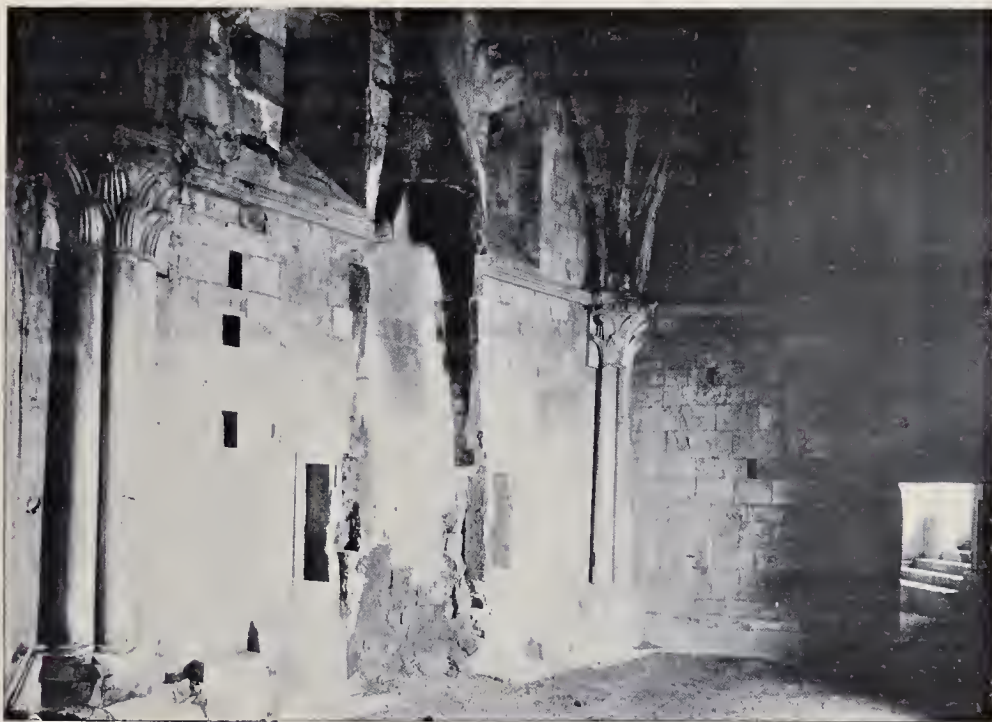
FIG. 365. — CASTEL DEL MONTE. SALLE DU PREMIER ÉTAGE.
