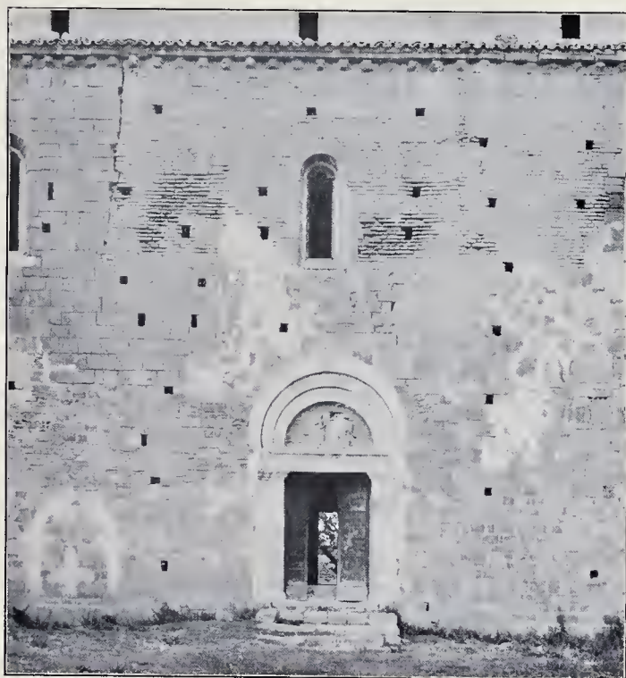
FIG. 237. — MUR LATÉRAL DE L'ÉGLISE SAN GIOVANNI IN VENERE; TROIS CONSTRUCTIONS SUPERPOSÉES.
