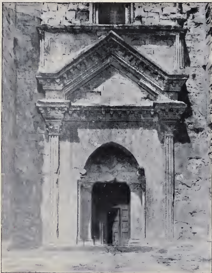
FIG. 361. — PORTE MONUMENTALE DE CASTEL DEL MONTE.
