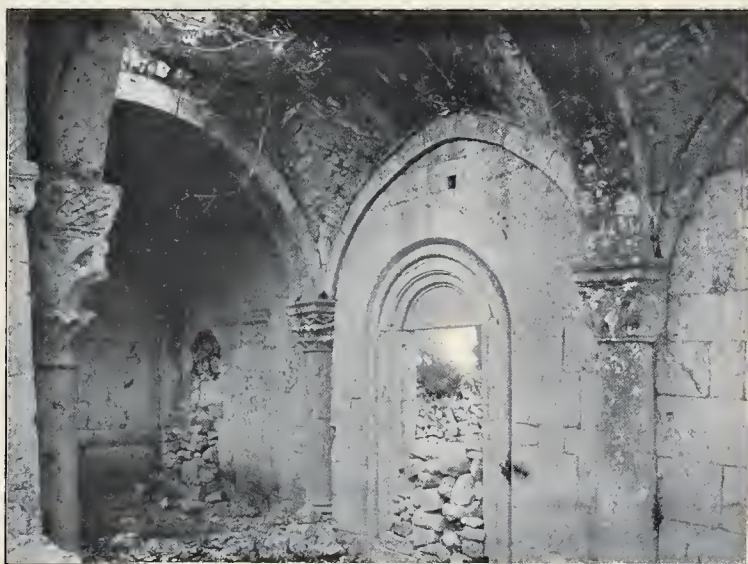
FIG. 328. — PORCHE RUINÉ DE L'ÉGLISE DE MONTE SAGRO, SUR LE MONT GARGANO.
