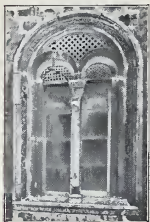
FIG. 150. — FENÊTRE BILOBÉE, A LA FAÇADE DE LA COLLÉGIALE DE BARLETTA.
