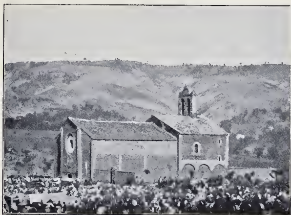
FIG. 246. — VUE DE L'ÉGLISE SANTA MARIA DI RONZANO (PROVINCE DE TERAMO).
