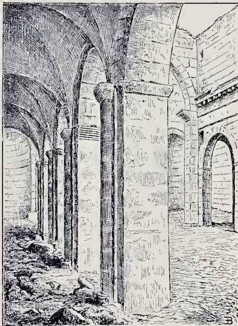
FIG. 70. — VUE INTÉRIEURE DE L'ÉGLISE RUINÉE DE SANTA MARIA LA LIBERA, PRÈS D'AQUINO (TERRE DE LABOUR).
