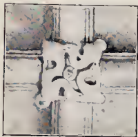
FIG. 359. — CLEF DE VOÛTE AU REZ-DE-CHAUSSÉE DE CASTEL DEL MONTE.
